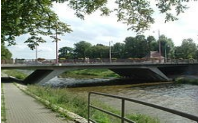
Pont Heinrich (Allemagne)
