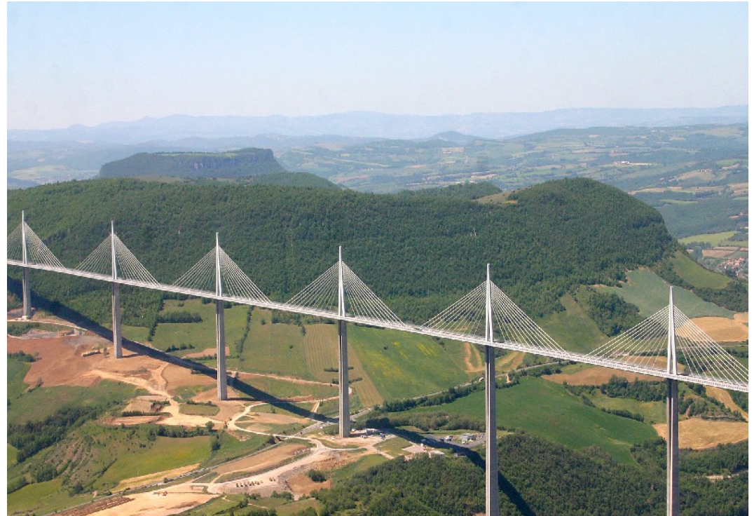
Viaduc de Millau
